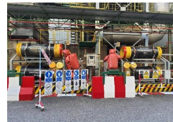
ภาพที่ 6 OC สั่งการให้ DeNOx Technician และ Mill Technician เข้าทำการปิดวาล์วที่ Drum ของถังแอมโมเนียที่ Ammonia Station
